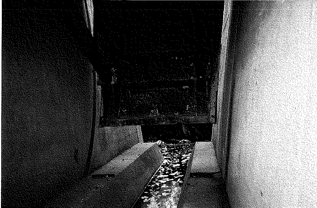
Foto n° 1 – Paratoia dello sbarramento n° 1, sollevata pur in assenza di acqua nell'invaso (26/9/2003)
